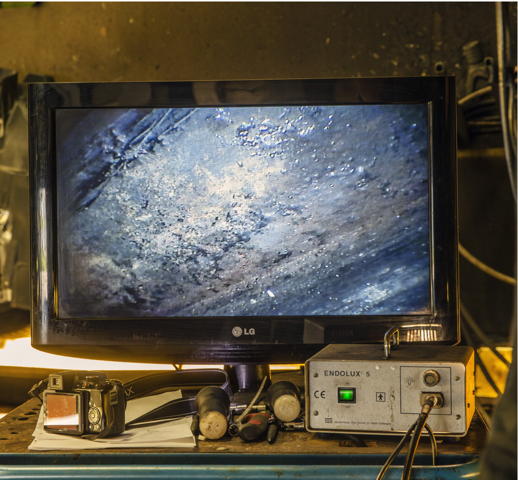
Bilden är tagen med fiberoptisk kamera inne i motorvaggans balkar. Bilden visar tydliga rostblåsor. De raka strecken i bildens övre vänstra hörn är sannolikt barr som har virvlat in i vaggan och förkolnat. Vaggan är av stålplåt, flera konkurrenter använder aluminium. Godset i vaggan är så pass grovt att det kommer att ta många år innan rostangreppen blir så omfattande att de får allvarliga strukturella konsekvenser.
