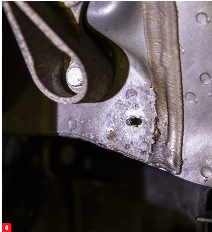
4. "Piggen" i mitten av bilden är infästningen till filtinnerskärmen. Den brunrå strängen är pvc-lim som tätar och skyddar en plåtskarv. Filtinnerskärmen har legat mot plåten och gett rost. Rosten i sin tur gör att lacken flagnar och att tätningen släpper och öppnar upp för att vatten letar sig in mellan fog och skarv. Tidigare när vi sett den här typen av skador har grundfärgen tenderat att lossna vilket ytterligare påskyndar rostprocessen.
