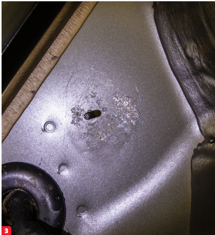
3. Här har innerskärmen av filtmaterial legat direkt mot plåten och fungerat som ett vätvarmt omslag. På tidigare Volvogenerationer konstruerades innerskärmarna med hårdplastskoningar vid infästningspunkten och runt hjulhuskanten. Där innerskärm mötte plåt fanns inget absorberande material. En betydligt bättre lösning än dagens helfiltinnerskärmar menar Vi Bilägares rostskyddsexpert Thomas Widström.
